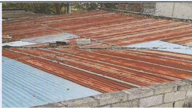
Foto 4: Sustitucion de lamina y estructura de techo en el area de la cancha
