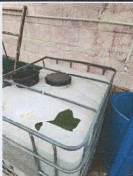
Foto 5: Sustitucion de deposito de agua 750lts.
