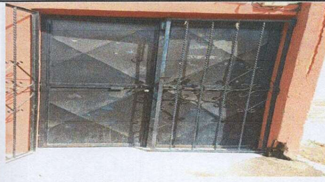
Foto 2: Sustitucion e instalacion de porton en area de ingreso de escuela de 2.10 mt. De altura por 1.54 m de ancho
